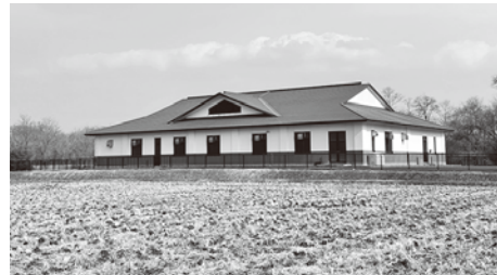
永南地区農業集落排水処理場
