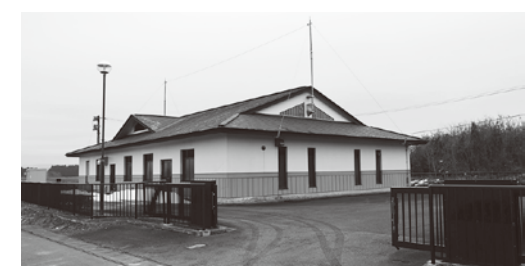
三ヶ尻地区農集排水処理施設
