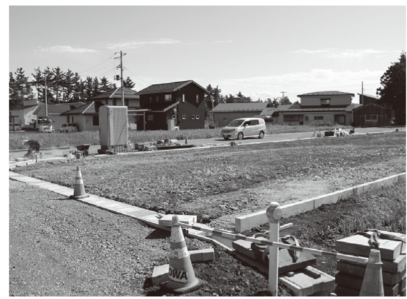
住宅団地の造成が進む 谷地下地区
