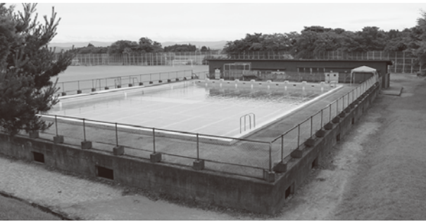
老朽化が見られる 金ケ崎中学校プール
