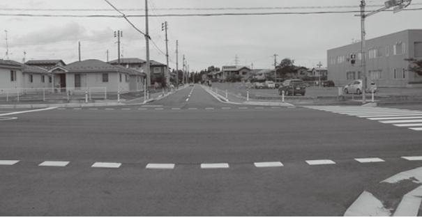
改良工事が行われた 町道野田・前野線
