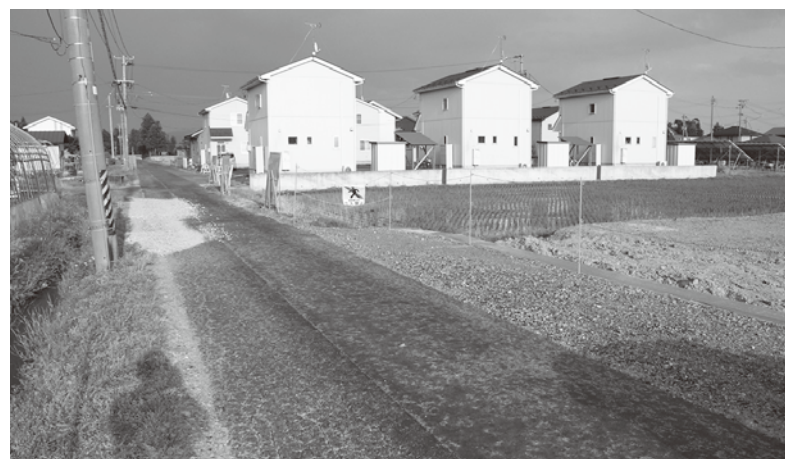
工事終了後には 復旧をお願いします (南方地区)
