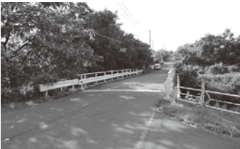
橋梁寿命化事業 （下波川橋）
