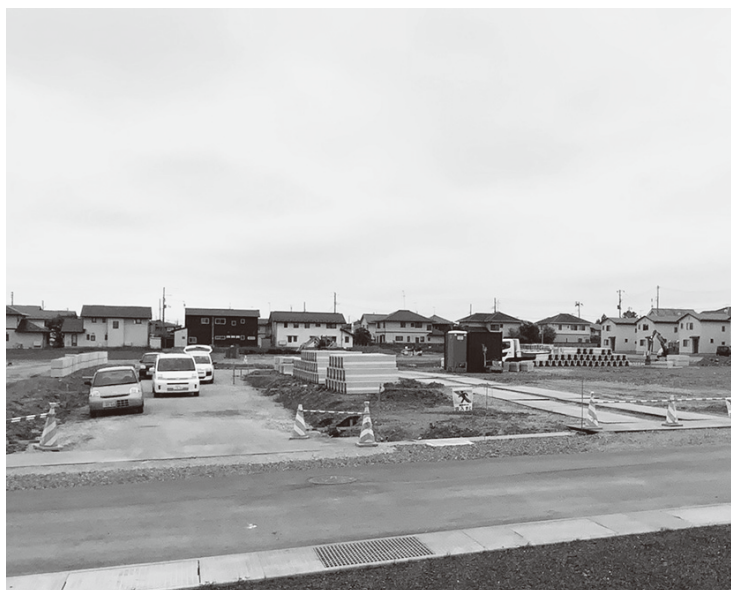
宅地開発が進む横道地区
