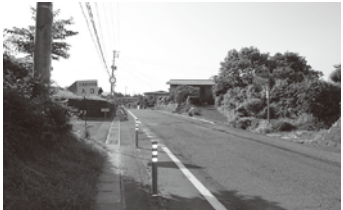
町道舗装補修事業 （中江雨溜木丁線）
