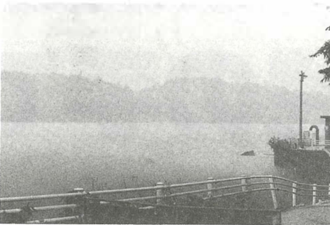
決壊が心配された千貫石堤
