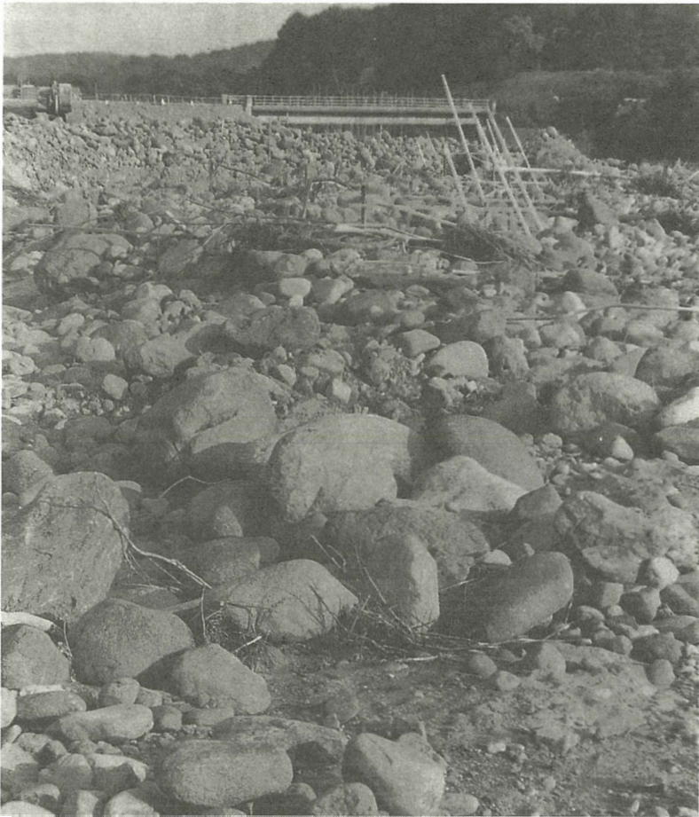
復旧工事を待つキッツ川上流
