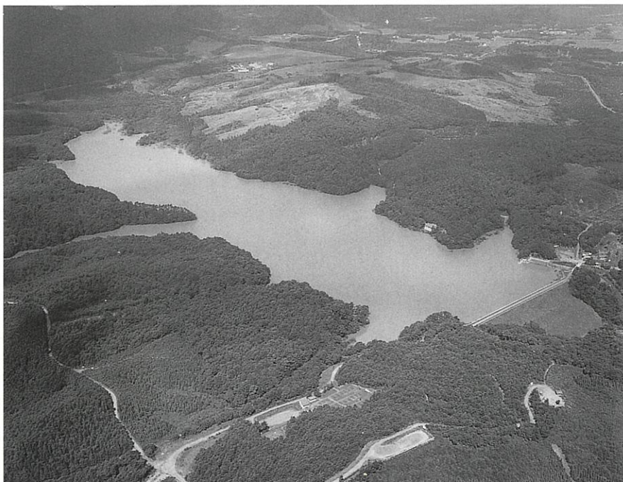
貯水能力500万tの千貫石堤は、今回の水害で重要な役割を果たした。(西根千貫石)
