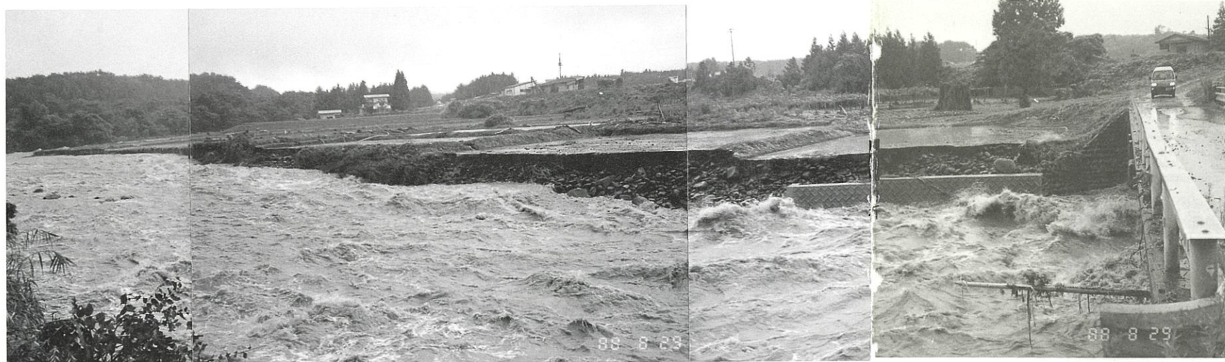
増水した川の水は、激流となり護岸を削りしだいに川巾を広げていった。(永栄島ノ海)
