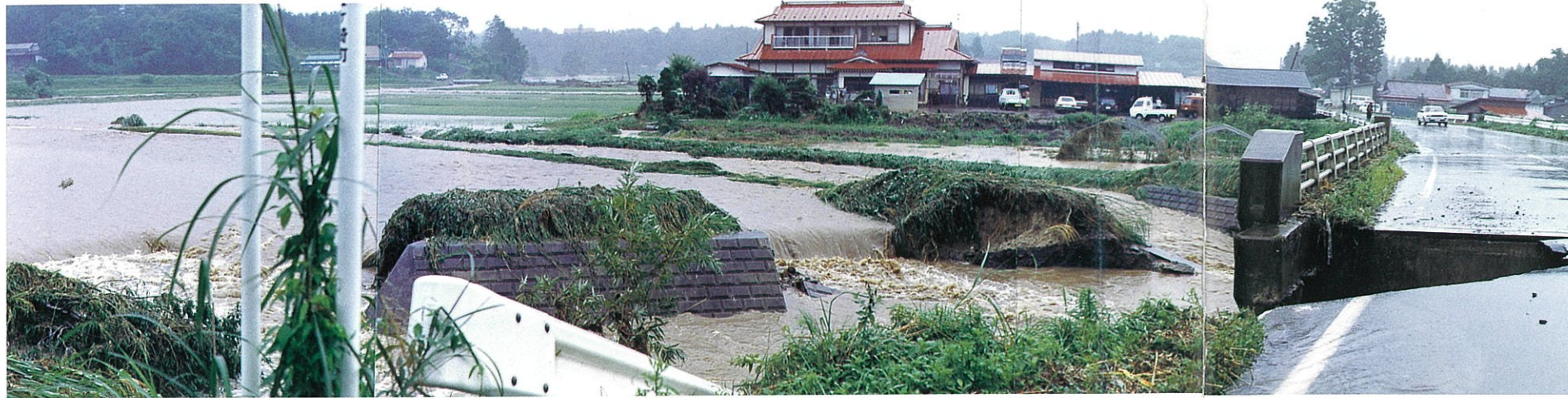
集中豪雨で川は氾濫し、水田は冠水し、住宅は床上浸水し、川護岸は崩壊し、橋は決壊した。(西根李田)
