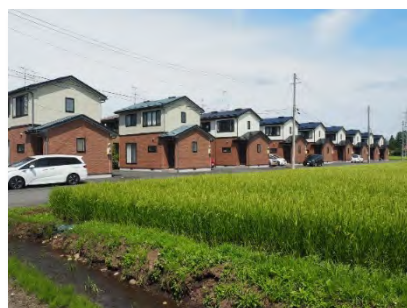
横道住宅団地
