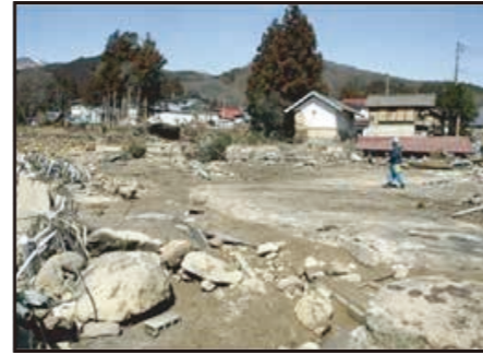
濁流が襲ったため池下流の集落 写真出典：農林水産省 Web サイト
