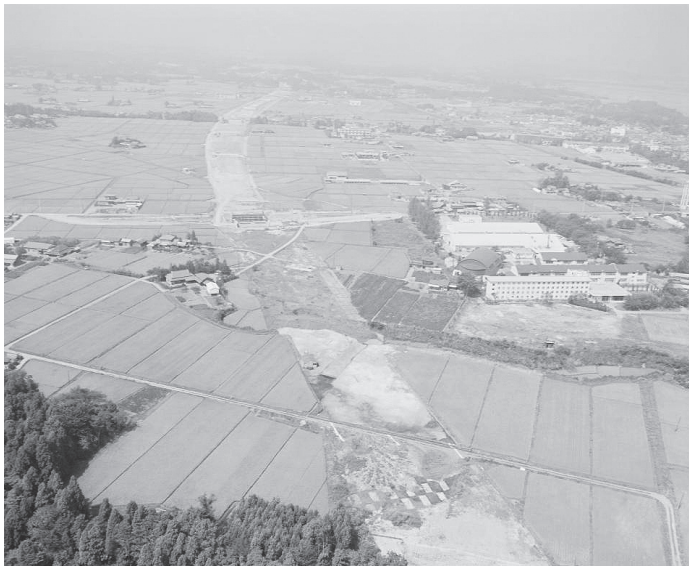
東北縦貫自動車道調査の様子
