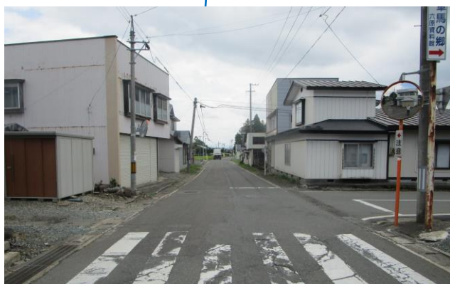
県道前沢北上線の西側付近 (センターラインが引けない区間があり車の すれ違いが困難であり歩行者の通行は危険)
