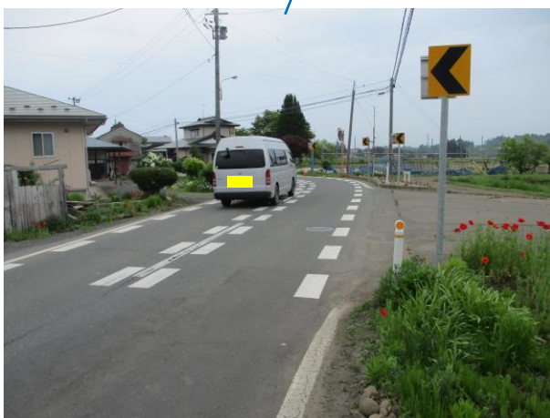
急なカーブのため見通しが効かない ため歩行者の通行が困難
