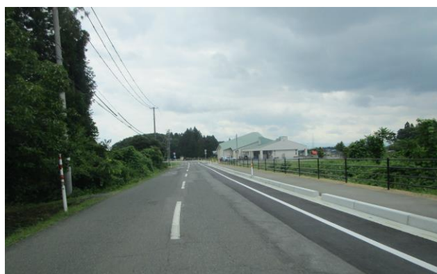
六原幼稚園付近 (工事完成箇所)
