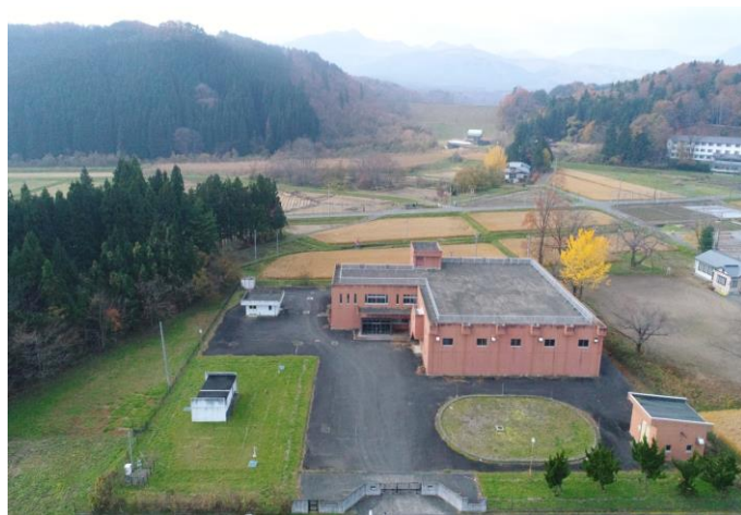
千貫石浄水場 処理能力10,000m 3 /D
