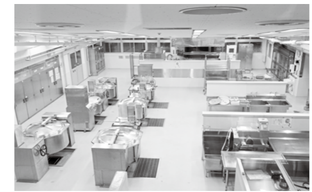
学校給食センター調理室
