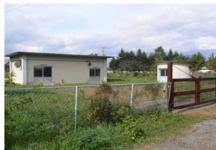
高谷野原浄水場
