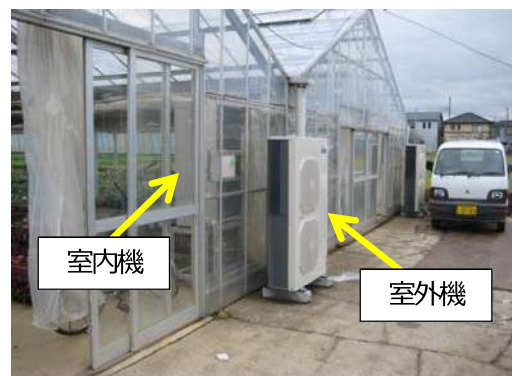
室内機と室外機の適切な設置例
