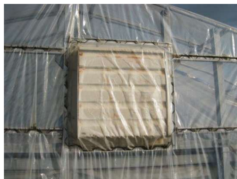
換気扇のシャッターを目張り
