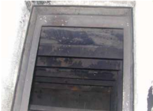
腐食抑制剤を使用している缶体
