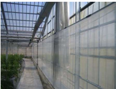
妻面のカーテンの隙間対策①
