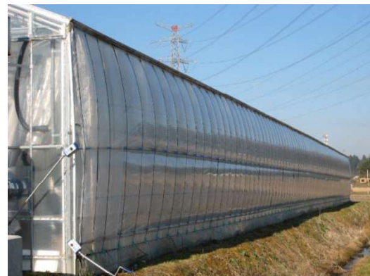
空気膜2重被覆（側面部）
