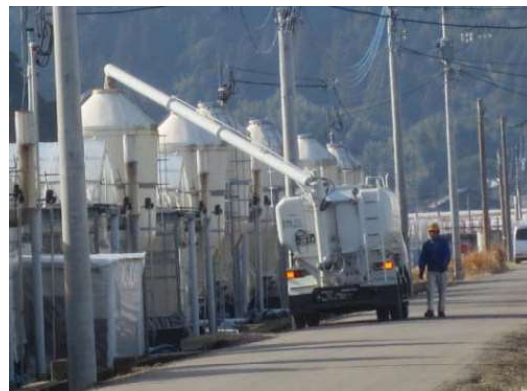
貯蔵タンクへの燃料の投入
