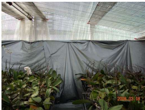
温室北面へ断熱資材を固定張り
