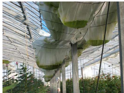
金魚鉢状に膨らんだ内張カーテン
