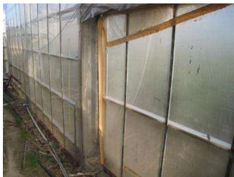
外張被覆の隙間を目張り
