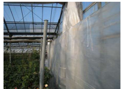
妻面のカーテンの隙間対策②
