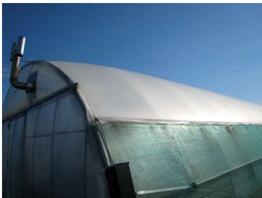
空気膜2重被覆（屋根部）
