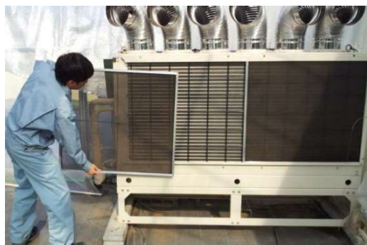
エアフィルターを取り外す
