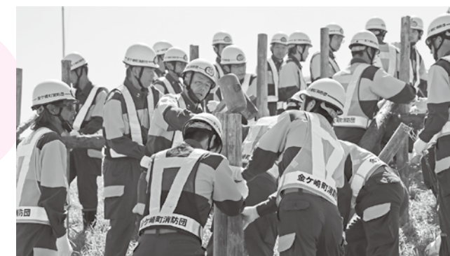
杭打ち積み土の工法を行う消防団員
