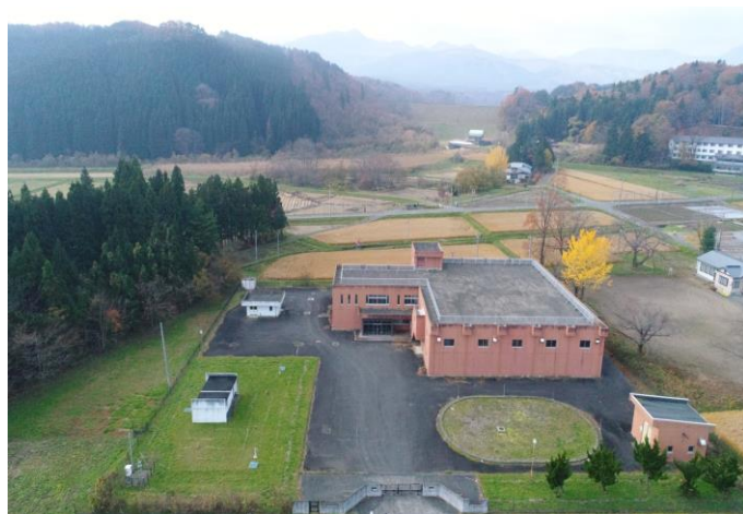
千貫石浄水場 処理能力10,000 \text{m}^3/\text{D}
