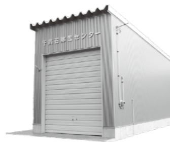
千貫石地区の除雪センター
