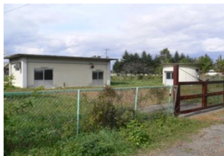
高谷野原浄水場
