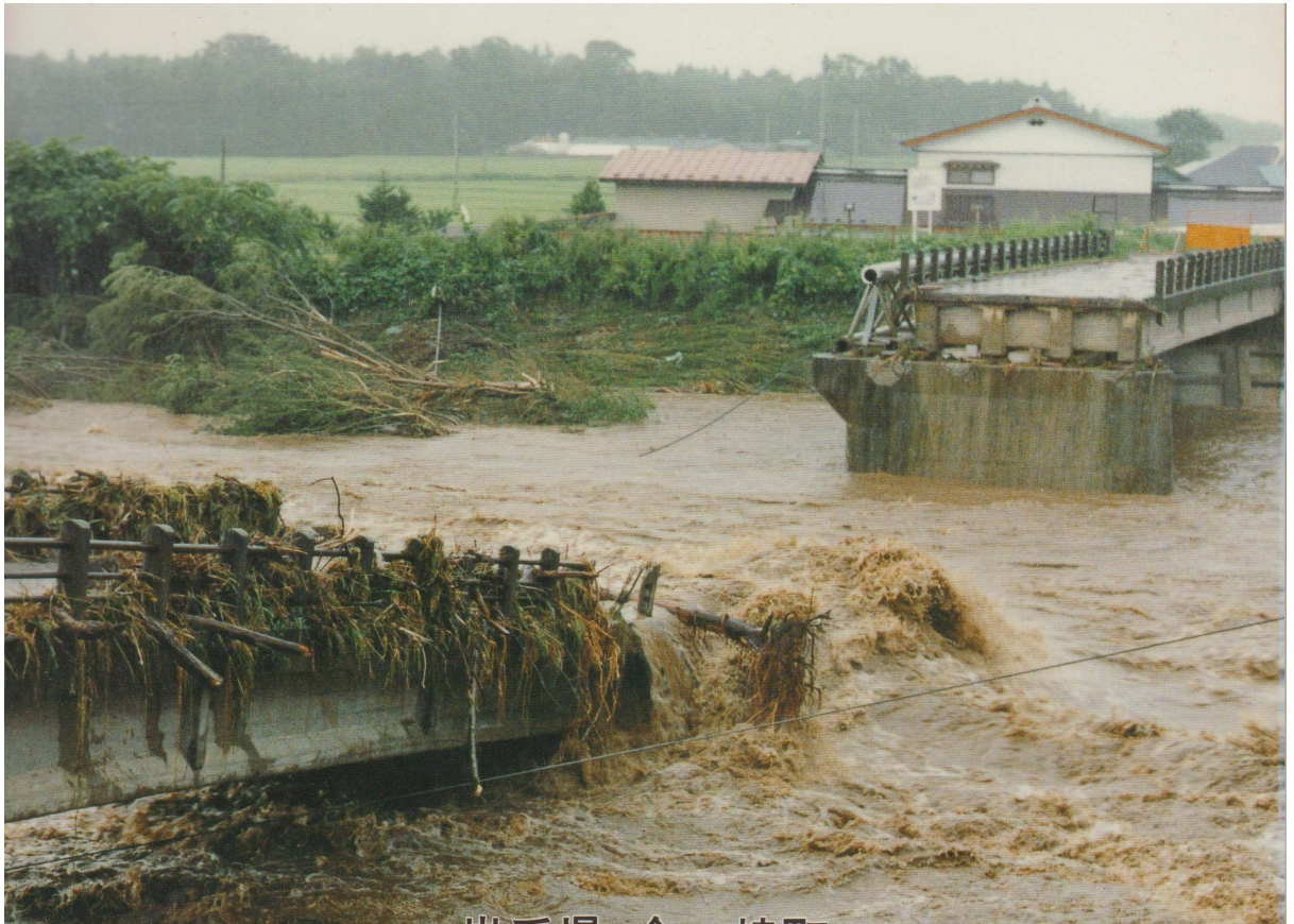
昭和63年8月水害 一級河川北上川水系黒沢川「川原田橋」流失の状況
