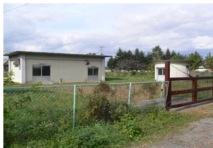
高谷野原浄水場
