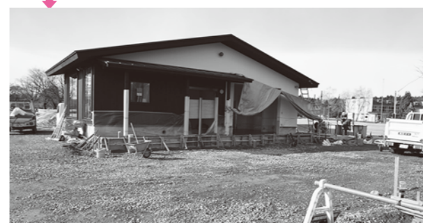
外回りの舗装工事をします
