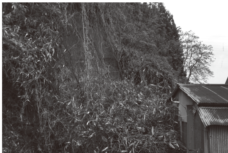
5月の大雨で がけくずれを起こした急傾斜地 (永徳寺地内)
