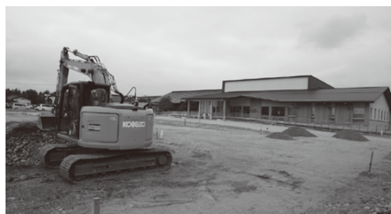
診療所 外構工事
