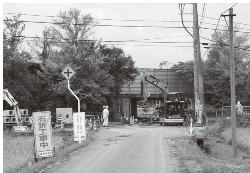
工事が進む交差点 信号機の設置を (下平沢地内)
