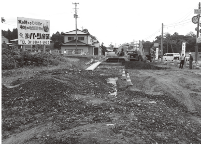
工事が進む国道4号線三ヶ尻交差点付近
