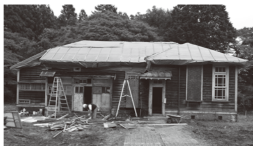
補修工事が進められている軍馬補充部官舎(六原)
