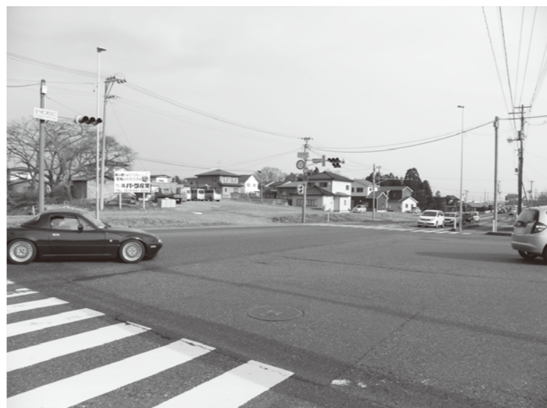
交差点改良工事中の国道4号
