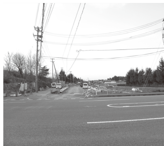
工事が進む東町・荒巻線
