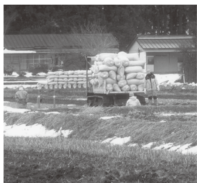
米の安定生産をめざし もみがらを活用し 暗きよ排水工事
