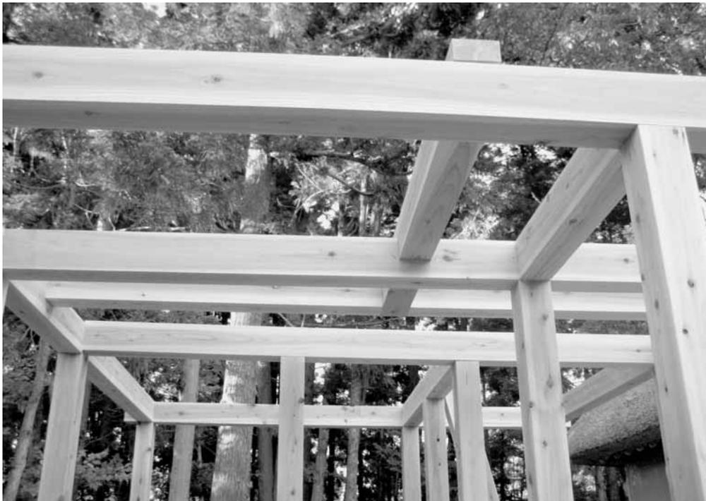
木造軸組み工法の一例
