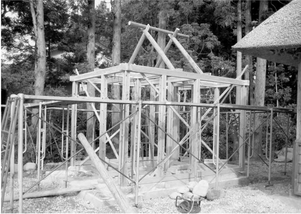
木造軸組み工法の一例
