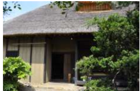
城内諏訪小路重要伝統的建造物群保存地区の茅葺き屋根
