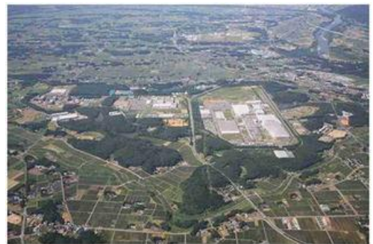
航空写真 岩手中部（金ケ崎）工業団地
