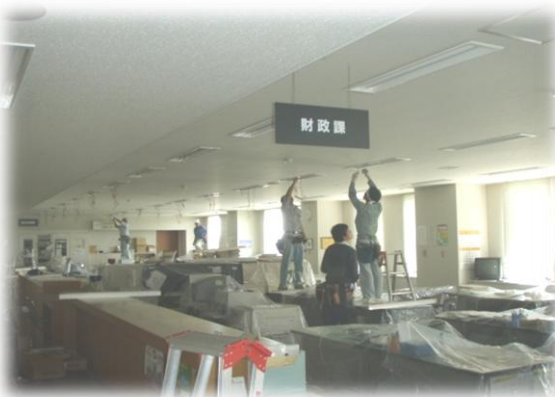
LED交換工事作業
